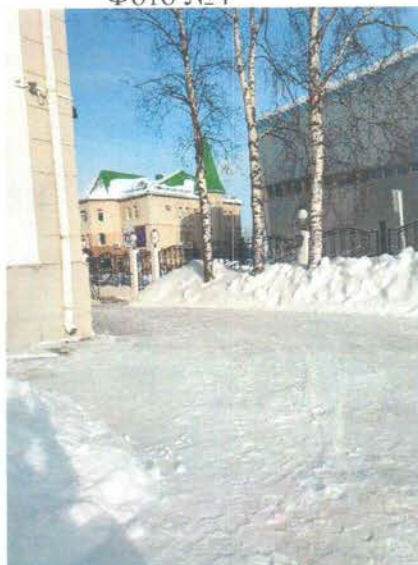
Вход (входы) в здание
